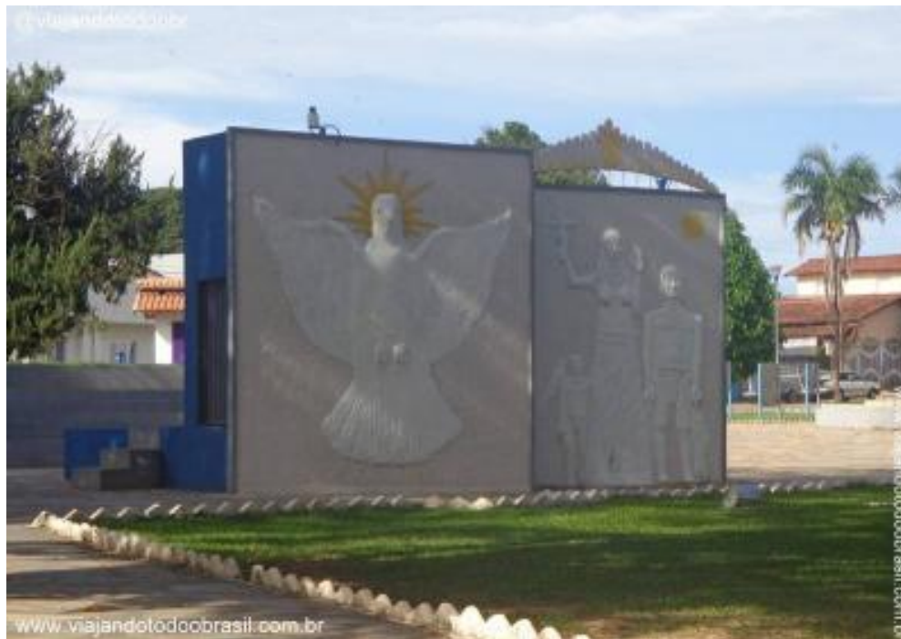
Figura 1 – Praça Damiana da Cunha anterior a restauração
